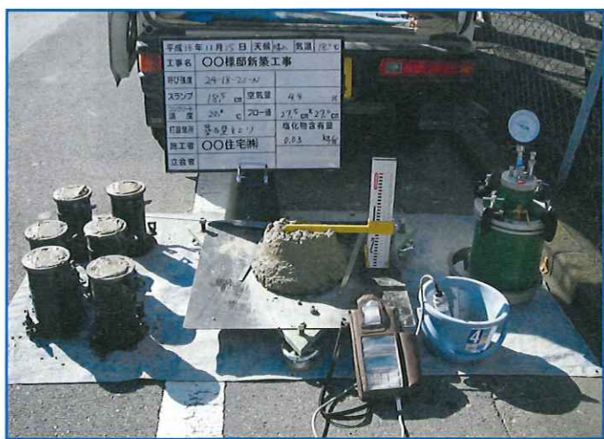
打設時の現場試験
