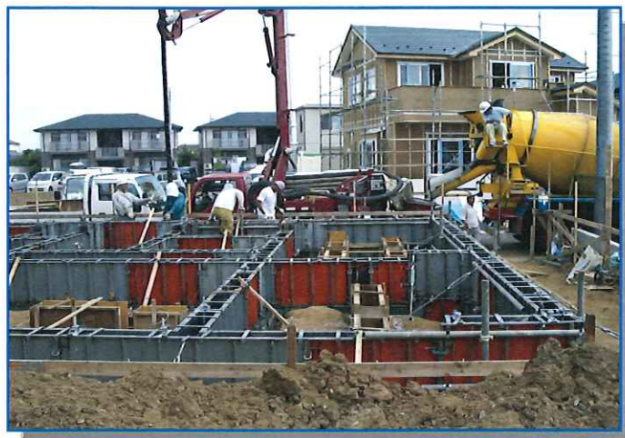
コンクリート打設現場での採取
